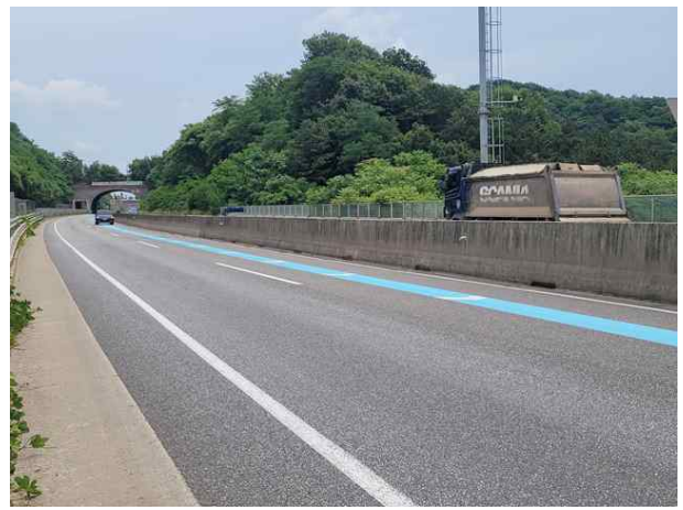
난간 및 연석 전경
